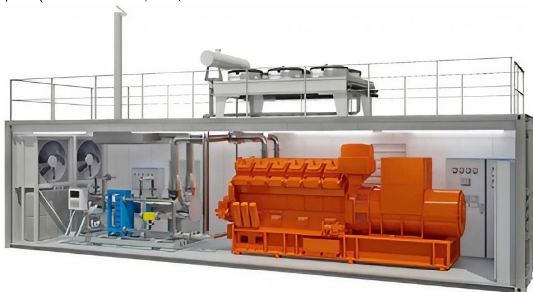
Рис. 5. Конструкция блочно-модульной электростанции
